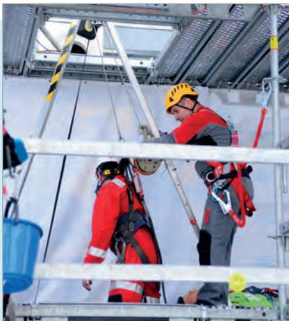
**Рис. 3.** Страхующий работник фиксирует карабин троса лебедки за кольцо спасательной привязи работающего, переводит лебедку в режим «спуск» и контролирует вытяжение троса лебедки, обеспечивая беспрепятственный спуск работающего в ОЗП
